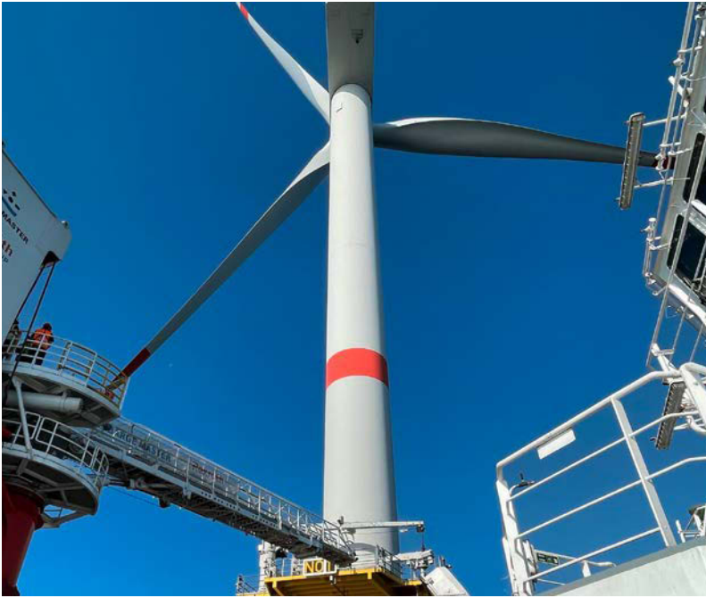
Wartung des Offshore-Windparks Nordsee Ost durch Instandhaltungsdienstleister Xervon Wind
