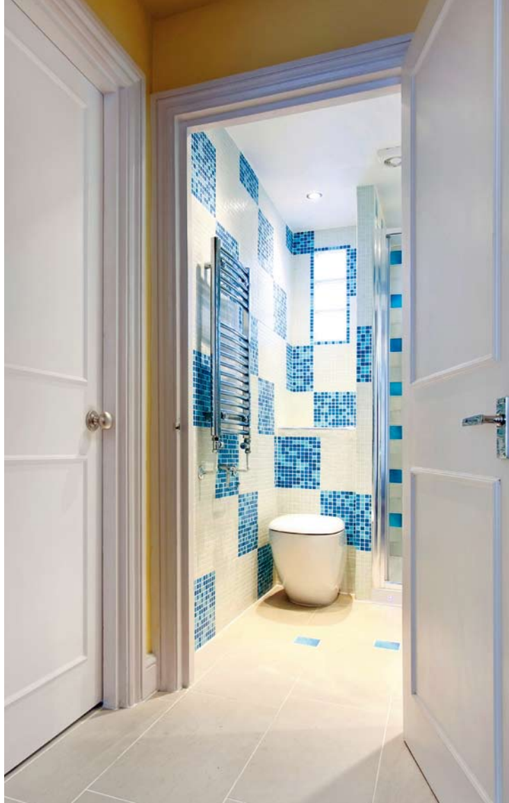
Ein Handtuchkörper lässt sich optisch sehr schön in ein Bad integrieren, seine Leistung reicht jedoch alleine oft nicht aus
